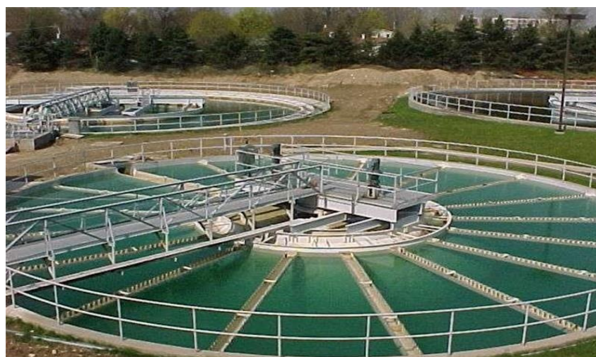
شکل ۱. نمایی از تصفیه‌خانه خرم آباد
