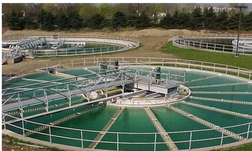
شکل ۱. نمایی از تصفیه‌خانه خرم آباد
