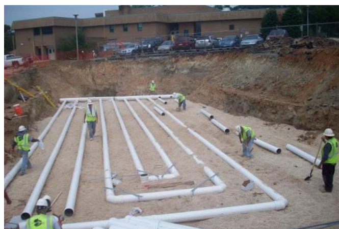
شکل ۵. تصویری از نحوه استقرار لوله‌های پلی اتیلنی مربوط به یک سیستم دالان زمین‌گرمایی
