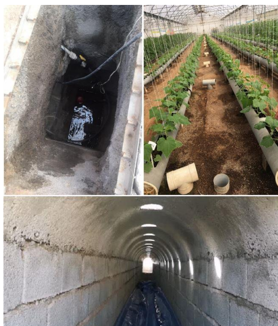
شکل ۸. تصاویری از دالان زمین‌گرمایی احداث‌شده در گلخانه منطقه کوهسار کرج
