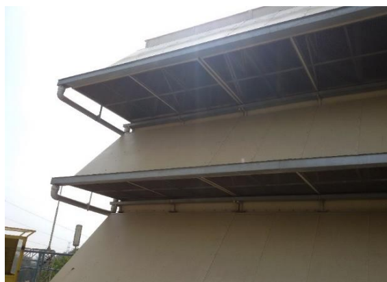
شکل ۹. نصب مسیر ناودانی انتقال آب باران (نیروگاه شیراز)
