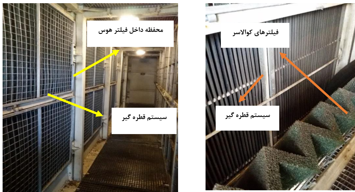
شکل ۸. نصب سیستم قطره‌گیر و فیلترهای کوالسر در نیروگاه نکا
